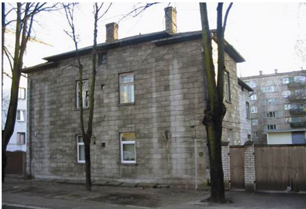
Рис. 1. Здание из автоклавного газобетона без наружной отделки. 1939 г.п., г. Рига, ул. Эльвирас, 15
